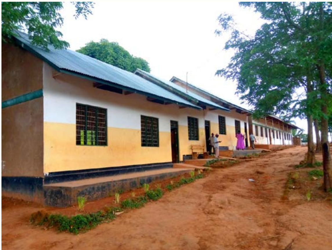
Majengo ya madarasa na ofisi ya walimu yaliyojengwa kwa ushirikinao kati ya TANAPA na wananchi wa Chankele
